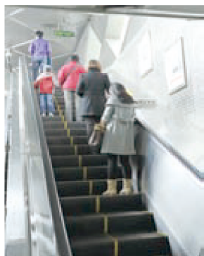
甲 运行中的自动扶梯
