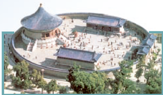
图 2.3-7 天坛的回音壁。人站在圆形围墙内附近说话，声音经过多次反射，可以在围墙的任何位置听到。
