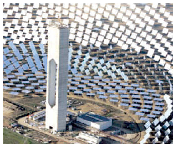
图4.3-5 塔式太阳能电站
