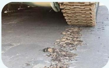
图 8.1-10 路面上的压痕
