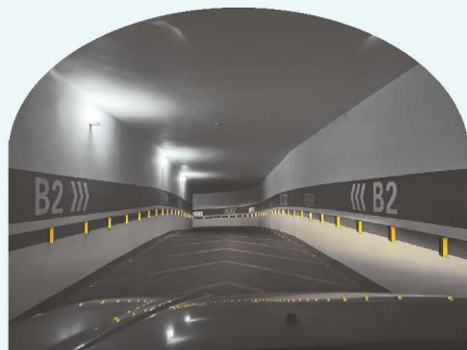
图 4.2-11 道路旁的角反射器
